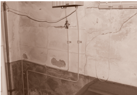
2018年9月6日に起こった北海道胆振東部地震による旧・展示本館への影響。各所で壁が剥落し、膨大な数のクラックが新たに生じました。(2018年9月13日撮影)
