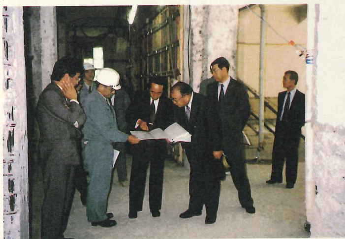
改修工事の現場を視察する丹保総長
