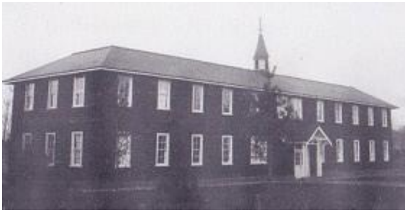
写真9 仙台学寮 竣工時：1925(大正14)年11月 所在地：現在の札幌市中央区北7条西12丁目 命名者：高橋是清(仙台藩ゆかりの元内閣総理大臣) 設計：田中豊太郎 施工：伊藤組(伊藤亀太郎)
