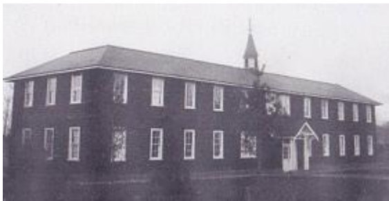
写真 9 仙台学寮 竣工時：1925(大正 14)年 11 月 所在地：現在の札幌市中央区北 7 条西 12 丁目 命名者：高橋是清(仙台藩ゆかりの元内閣総理大臣) 設計：田中豊太郎 施工：伊藤組(伊藤亀太郎)
