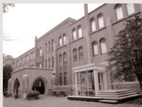
完成したバリアフリー玄関ならびに木製デッキ
