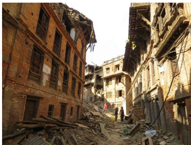
図2 崩壊した古都バクタプールの街（小倉清子さん撮影）
