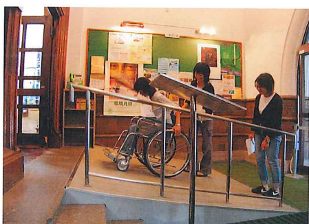
傾斜が急な玄関のスロープ
